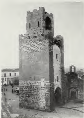
Oristano - Torre di S. Cristoforo o Porta Manna.
